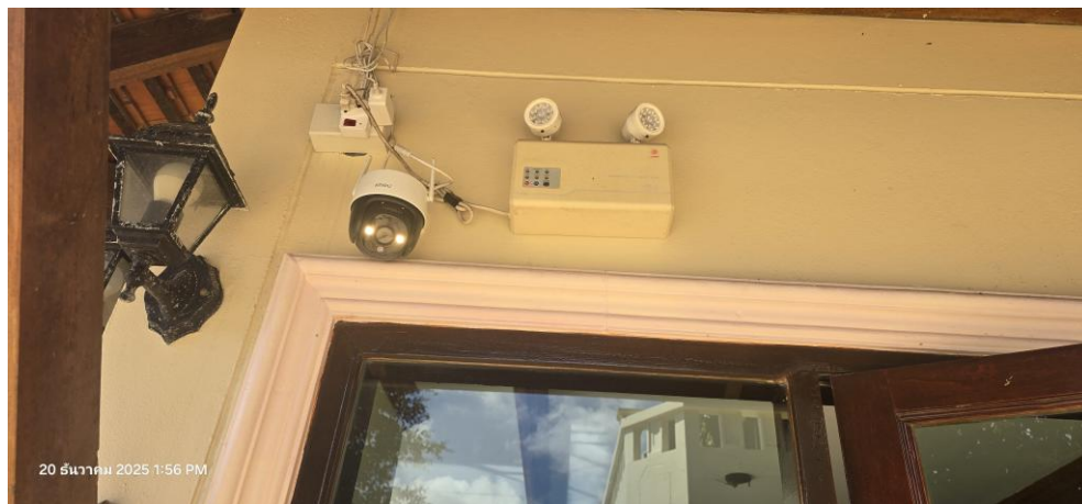
ภาพที่ 1 กล้อง CCTV และ ไฟฉุกเฉินภายนอกอาคาร
